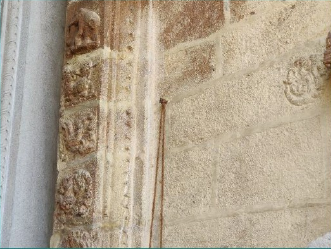
Fig 7.13 – 7.14 திருவெள்ளறை இராஜகோபுரம் - கல்காரத்தில் வடக்கு பக்கம் நிலைக்கால்களுக்கு அருகில் மேற்கு சுவற்றில் அடிக்கப்பட்ட இரும்பு ஆணியை காட்டும் படங்கள்
