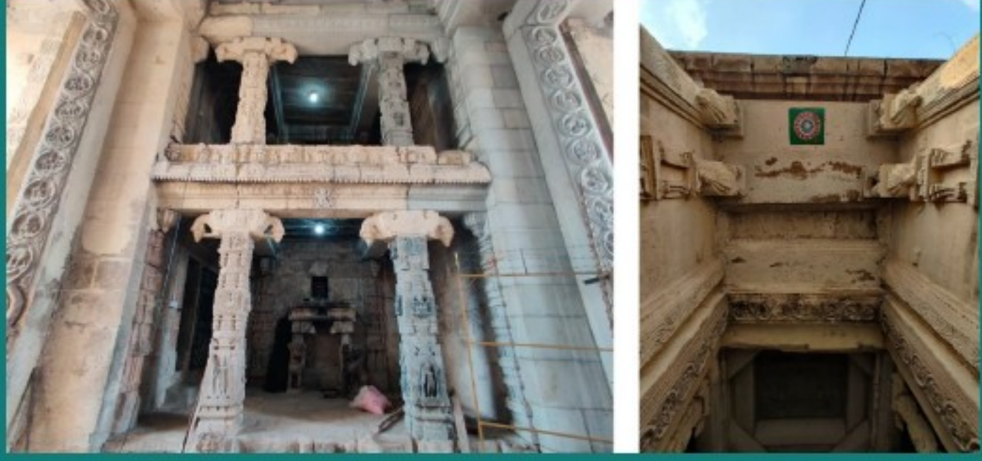
Fig 7.19 – 7.20 திருவெள்ளறை இராஜகோபுரம் - கல்காரத்தில் உள்புறம் பழைய தூண்கள், உத்திரங்கள், முக உத்திரங்களில் வெள்ளை கண்ணாம்பு அடிக்கப்பட்டிருப்பதை இந்த படத்தில் காணலாம்
