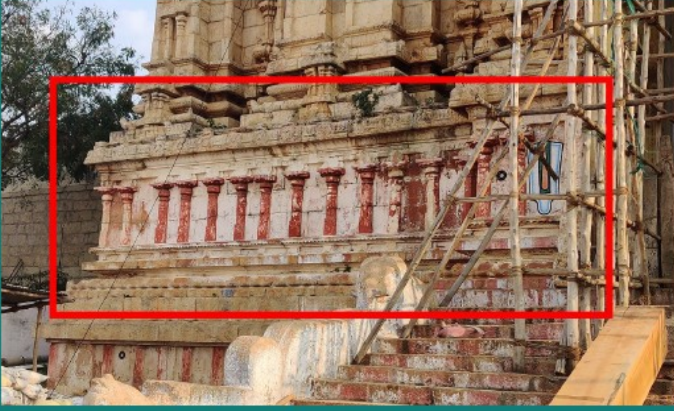
Fig 7.16 திருவெள்ளறை இராஜகோபுரம் - ஊடக்கு பக்கம் கல்காரத்தின் உபபீடத்தில், மற்றும் படிக்கட்டுகளில் வெள்ளை கண்ணாம்பு அடிக்கப்பட்டிருப்பதை இந்த படத்தில் காணலாம்
