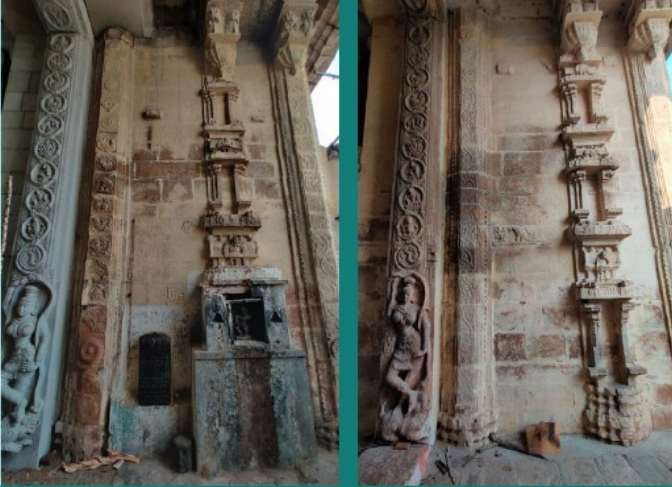
Fig 7.17 – 7.18 திருவெள்ளறை இராஜகோபுரம் - ஊடக்கு மற்றும் தெற்கு பக்கம் கல்காரத்தில் நிலைக்கால்களுக்கு அருகில் கிழக்கு சுவற்றில் வெள்ளை கண்ணாம்பு அடிக்கப்பட்டிருப்பதை இந்த படத்தில் காணலாம்
